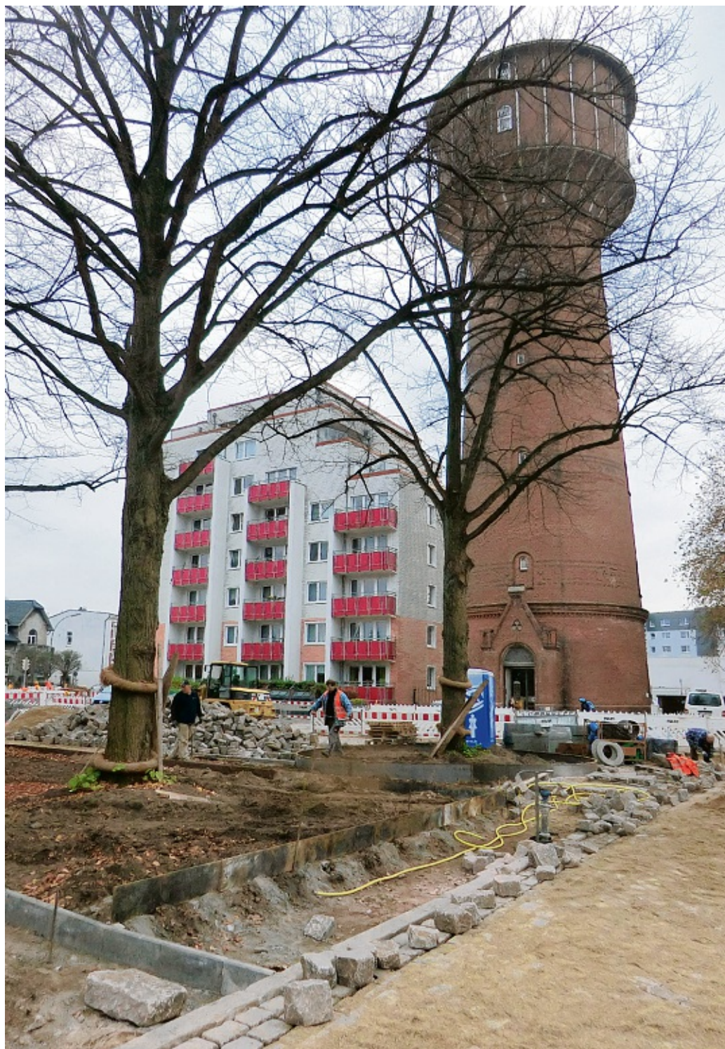
Noch sind die Bauarbeiter fleißig am Werk, doch bis zum 2. Dezember soll der neue Platz am Wasserturm fertiggestellt sein. Die Umgestaltung läuft seit August. CARSTEN PETERSEN
